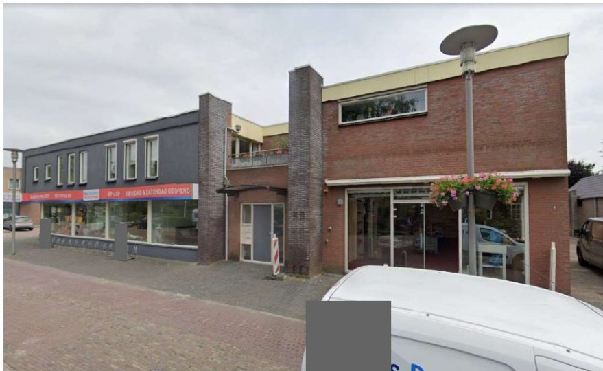
Aanzicht op de voormalige winkel 'Zwolsche Bazaar' gezien vanaf de Burgemeester Backxlaan
