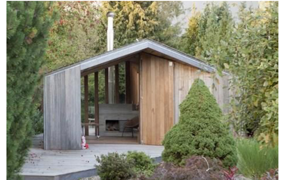
Veranda gekoppeld aan hoofdvolume en onderdeel van de architectuur als eigen objectgebonden buitenruimte
