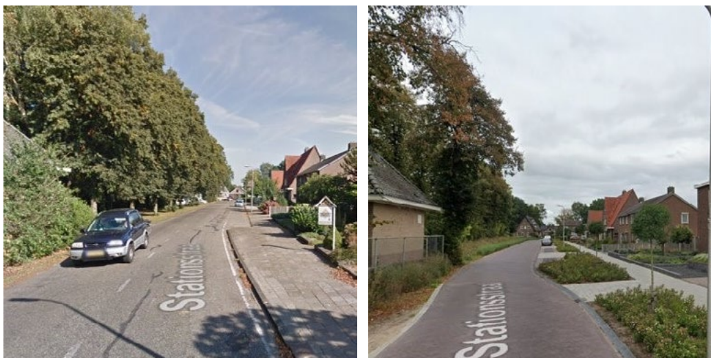
Figuur 5a: Stationsstraat, Lemelerveld. Bij dit integrale project is de weg versmald, tegelijkertijd vergroend en veiliger gemaakt. Daarnaast wordt er nu ecologisch beheerd. De bomen zijn in dit project behouden.
