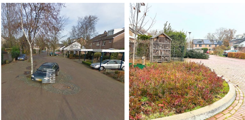
Figuur 5b: In de Westerhof is de verharding vervangen. Tegelijkertijd is het plein aantrekkelijker gemaakt door groen en speelmogelijkheden toe te voegen.
