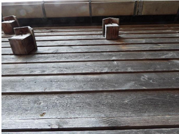
De planken sluiten strak op elkaar aan.
