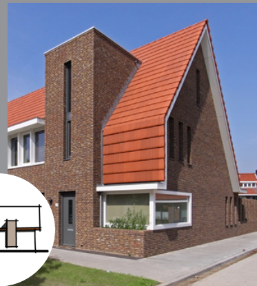
Verticaal element wat de goot doorbreekt.
