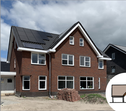
Twee verschillende kapvormen versterkt door diepteverschil in de gevel.
