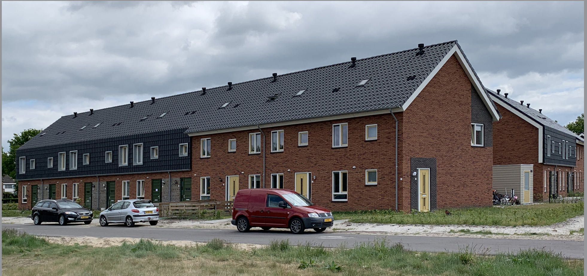
Een sterke verbijzondering waar een deel van de kap doorloopt in de gevel (2e fase Westerbouwlanden).
