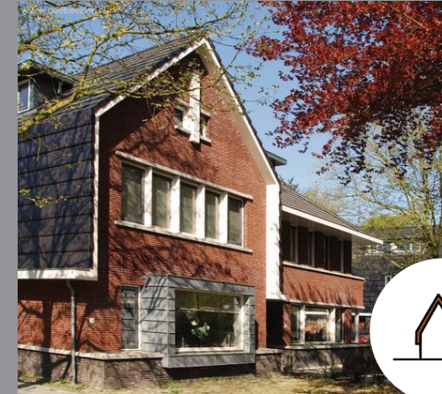
Het materiaal van het dak loopt voor een deel door in de gevel.
