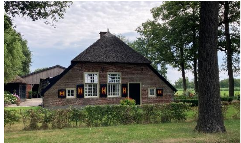
Voorbeeld traditionele streekeigen boerderij in baksteen, met een dak in riet met pannen
