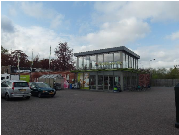
Plus-supermarkt in Nieuwleusen
