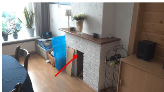
Foto 48 | verloren bekisting in de schouw
