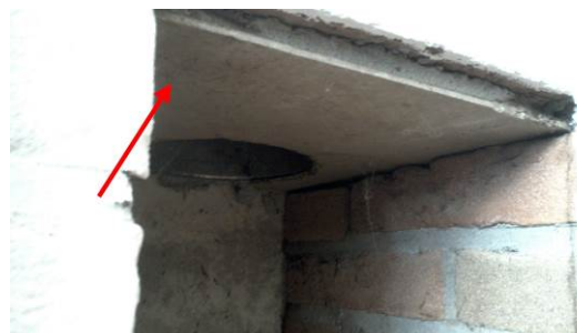
Foto 49 | verloren bekisting in de schouw
