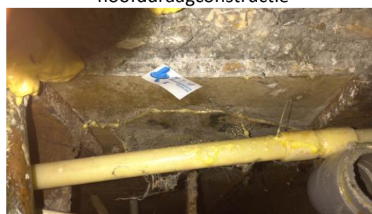
Foto 4 | verloren bekisting t.p.v. hoofddraagconstructie
