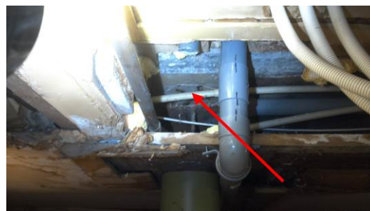
Foto 2 | verloren bekisting t.p.v. hoofddraagconstructie
