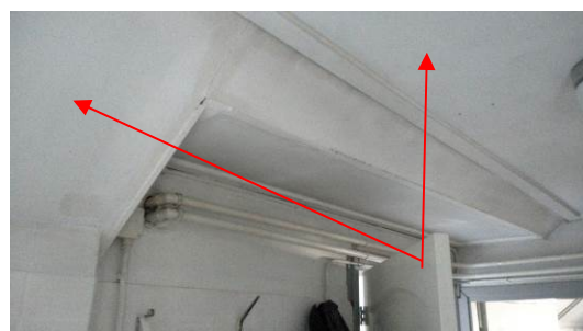
Foto 44 | plafond in het bijgebouw
