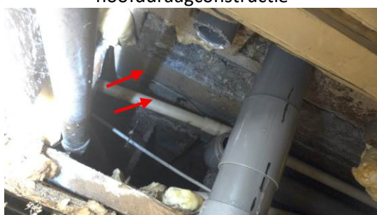
Foto 3 | verloren bekisting t.p.v. hoofddraagconstructie
