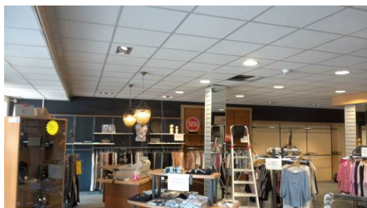
Foto 1 | verloren bekisting t.p.v. hoofddraagconstructie
