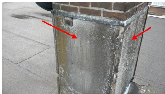
Foto 31 | plaatmateriaal om de schoorsteen
