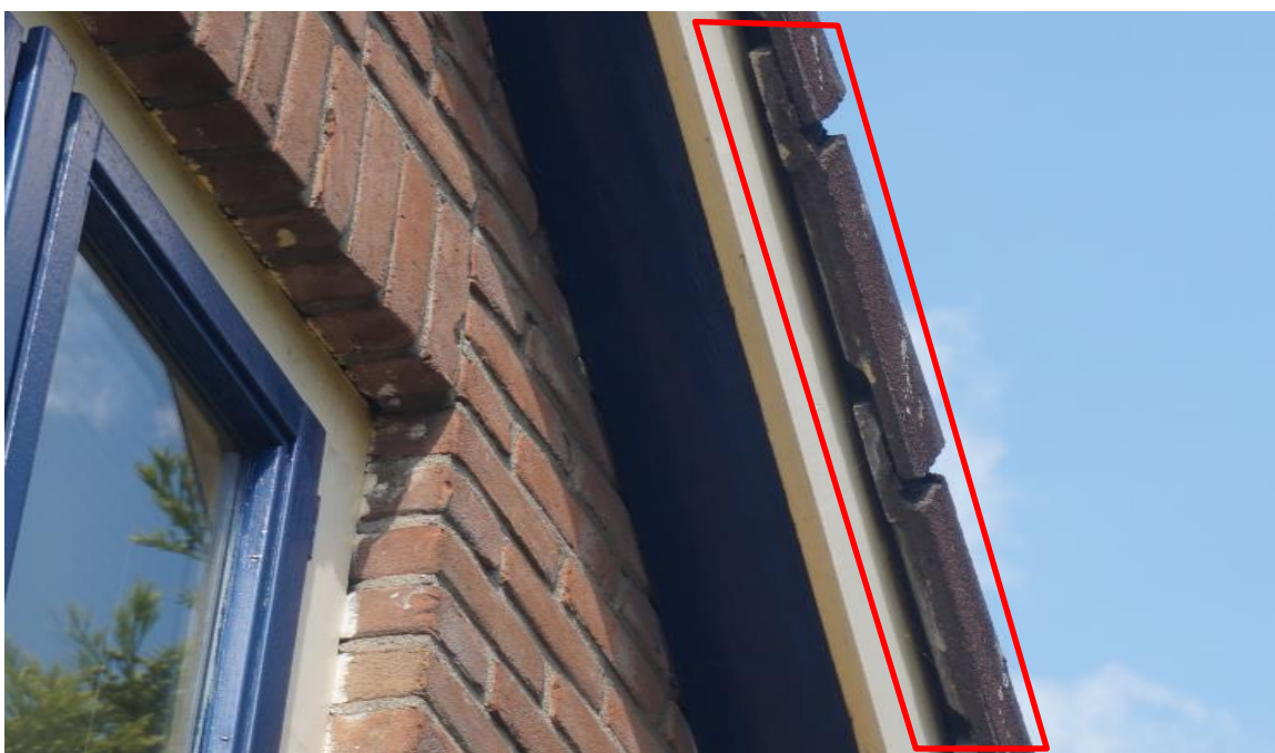
Figuur 5.2. Voorzijde woning met toegangsmogelijkheden voor vleermuizen onder de dakpannen.
