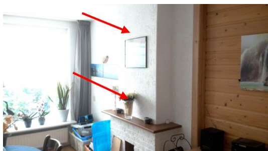
Foto 50 | rookkanaal begane grond
