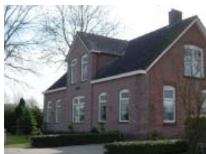
Verbouwde voormalige boerderij langs Meeleweg.
