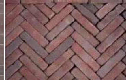
Voorbeeld materialisatie rijbaan
