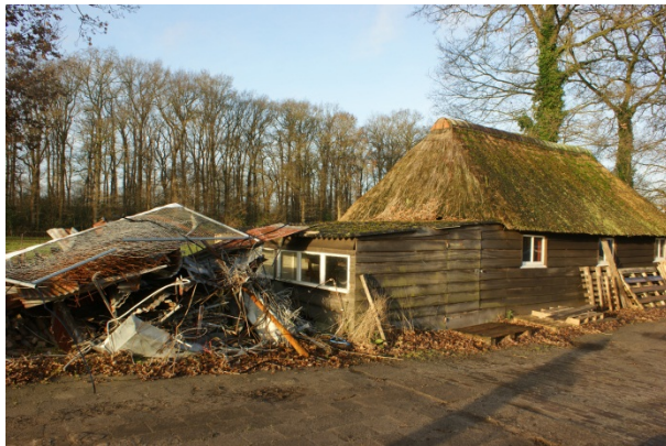
Te slopen houten schuur
