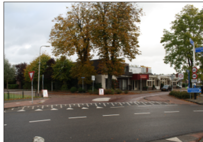
* locatie Jansen gezien vanaf Wagenmansbrug
