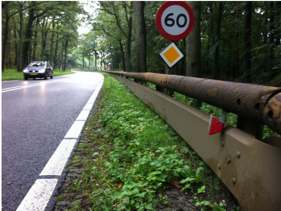
Afbeelding 12: Optie bermbeveiliging door houten geleiderail (voorbeeld: Eerde)
