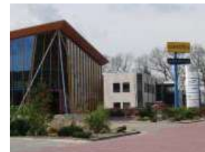
Expresieve vormgeving van een kantoorpand.
