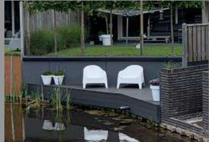
Gewenst voorbeeld van verlaagde kadewand over de hele kavelbreedte (1e fase Westerbouwlanden).
