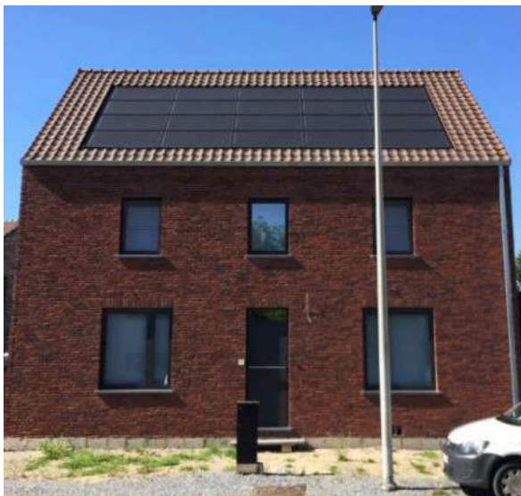
integratie pv panelen in het dak.
