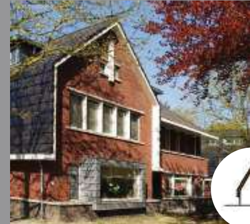
Het materiaal van het dak loopt voor een deel door in de gevel.
