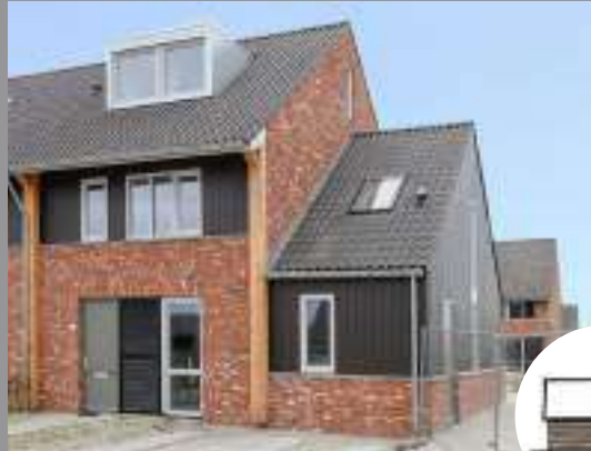
Duidelijk diepteverschil in de gevel versterkt door verschil in materiaal.
