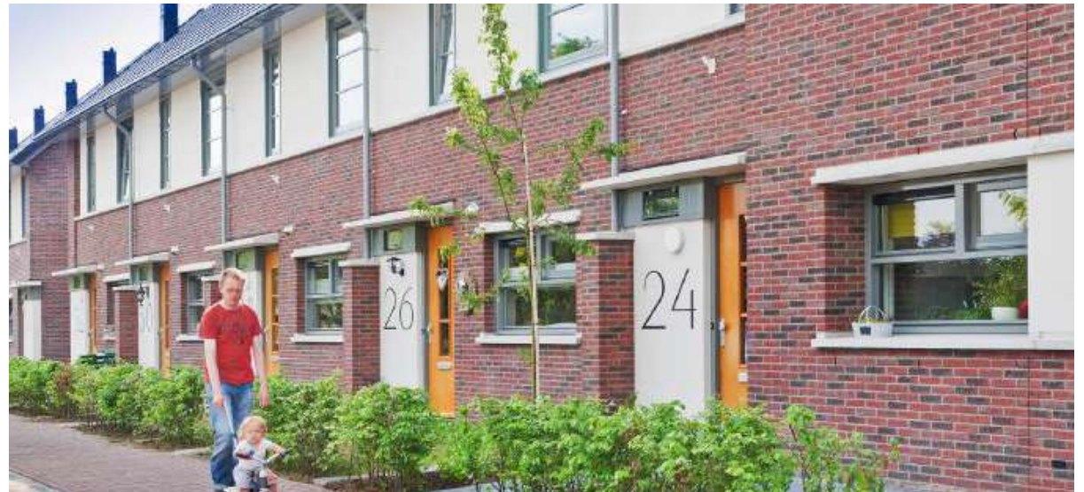
Een gevarieerd rijk gevelbeeld.
