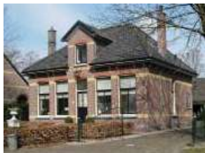
Monumentale onderwijzerswoning naast de voormalige school.
