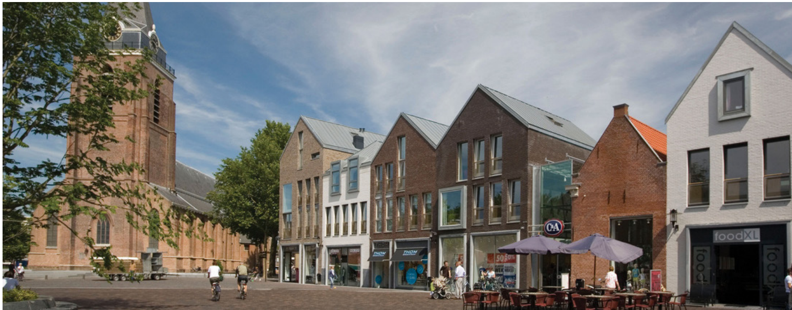
Een bebouwingwand van individuele panden (Groeneweg Van Der Meijden Architecten)
