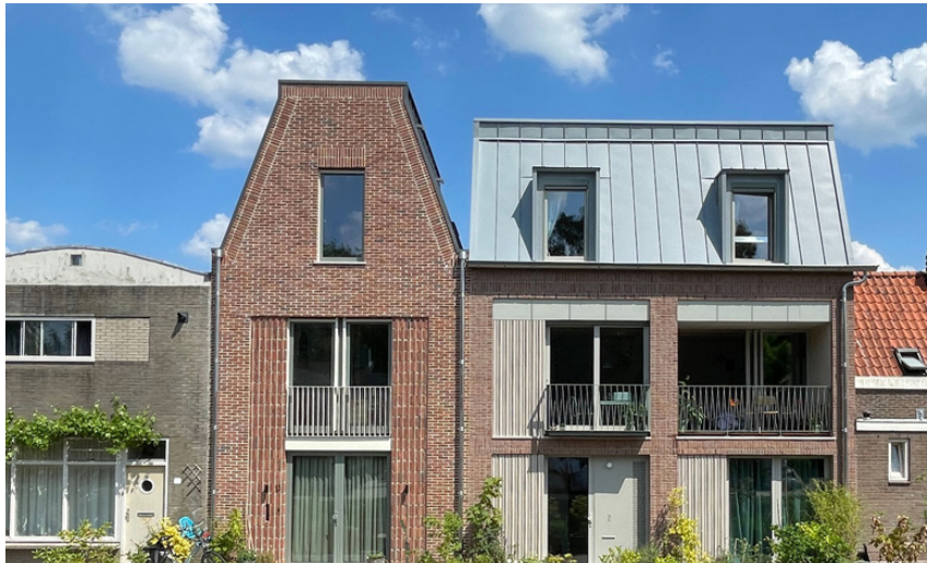
Variatie per pand d.m.v. verschil goothoogte, architectuur, materiaal en detail (Ontwerp en foto Zijdekwartier architecten)
