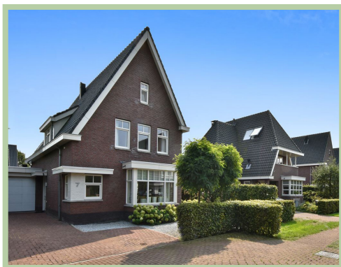
Kopgevels met overstek
