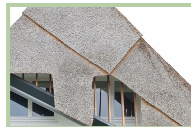
Op prominente hoeken zijn afwijkende dakvormen toegestaan
