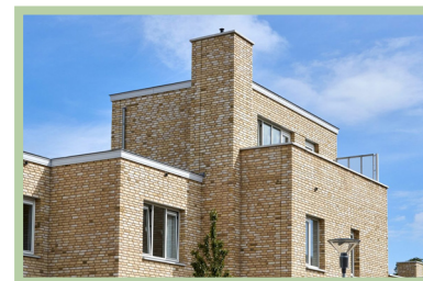
Bij één tweekapper is een plat dak toegestaan, maar is een bijzondere opbouw en duidelijke dakbeëindiging vereist
