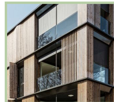
Diepte in de gevel
