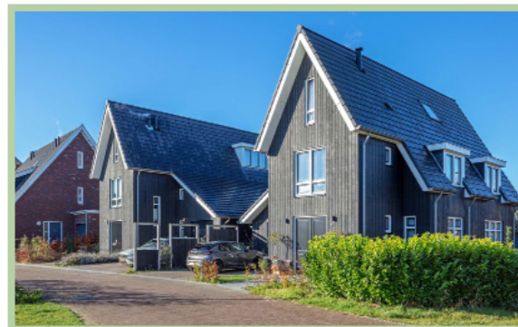
Gebakken klinkers als duurzame verharding
