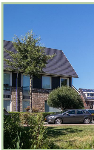
Langsgevel met overstek
