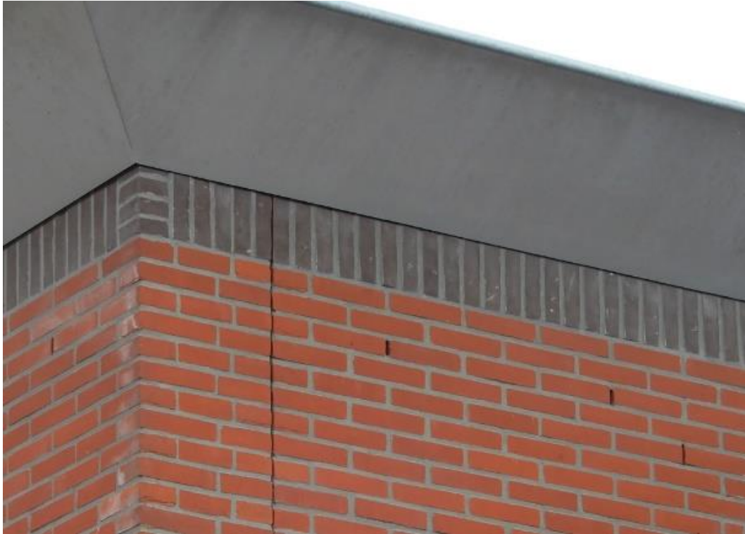
Figuur 8. Open stootvoegen.
