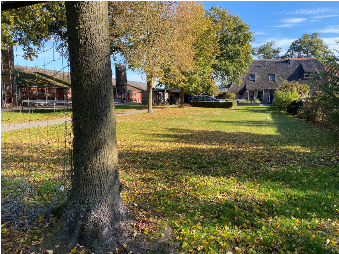
Boerderij en varkensstal aan Oosteinde 65 en 65a in Nieuwleusen.
