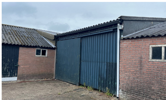
Afbeelding 6. Te amoveren aanpalende schuur (in gebruik om de auto binnen te zetten)
