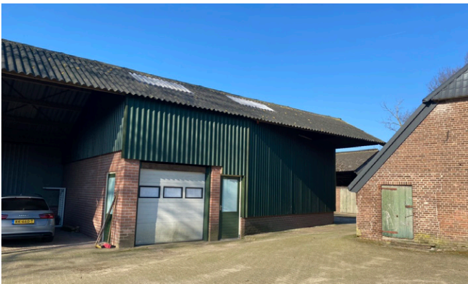
Afbeelding 7. Nieuwe schuur met damwand beplanting
