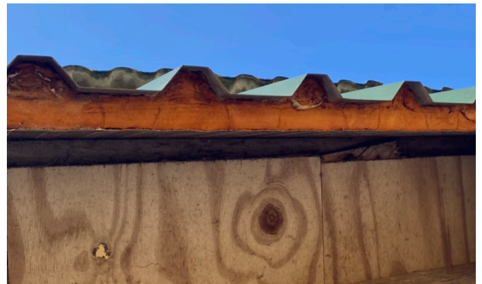
Afbeelding 8. Afwerking overgang damwand en stenenmuur geen invliegopeningen waargenomen
