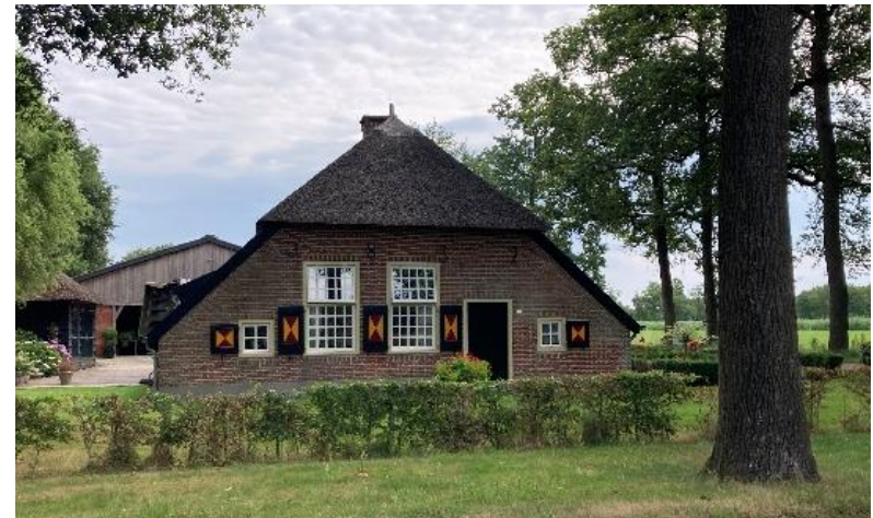
Voorbeeld traditionele streekeigen boerderij in baksteen, met een dak in riet met pannen
