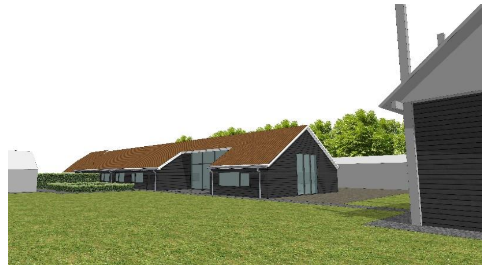
De opstal voorzien van streekeigen gevelbekleding en ingrepen t.b.v. daglicht
