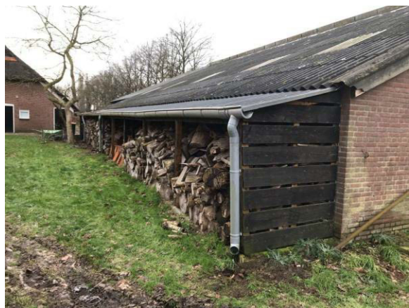
Figuur 8: Dak oostzijde met goot
