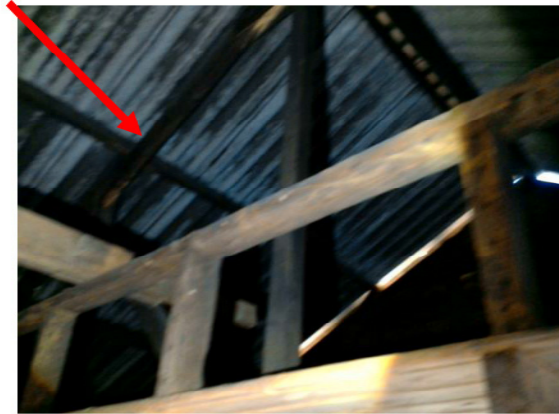
Foto 19 | Golfplaten op het dak
