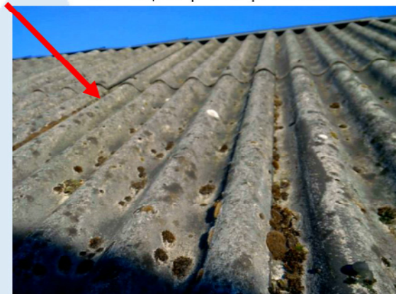
Foto 21 | Golfplaten op het dak
