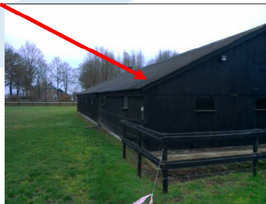
Foto 2 | Golfplaten op het dak
