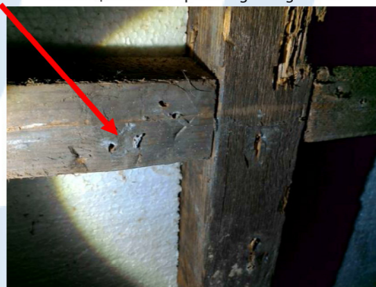
Foto 10 | Restanten plaat tegen regelwerk
