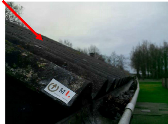
Foto 4 | Golflaten op het dak
