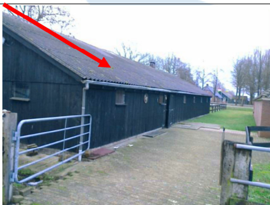
Foto 1 | Golfplaten op het dak
