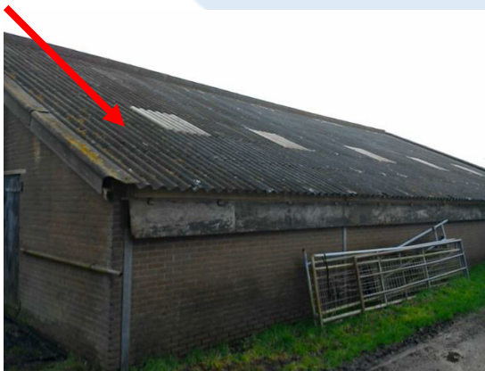
Foto 1 | Golfplaten op het dak
