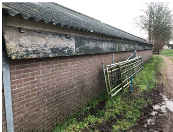
Figuur 9: Dak westzijde zonder goot
