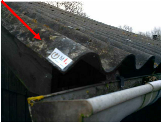
Foto 3 | Golflaten op het dak
