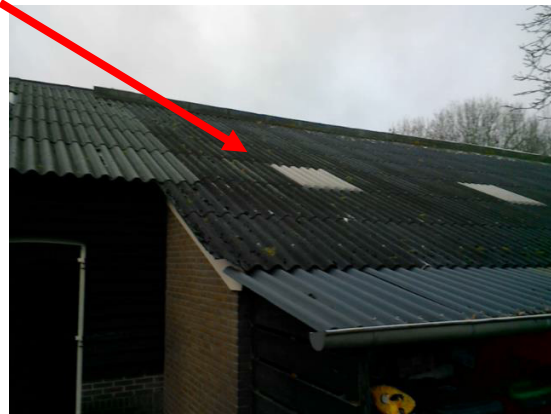
Foto 4 | Golfplaten op het dak
