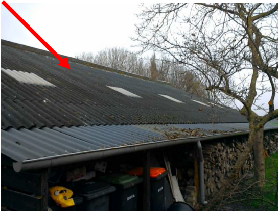
Foto 3 | Golfplaten op het dak
