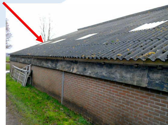
Foto 2 | Golfplaten op het dak
