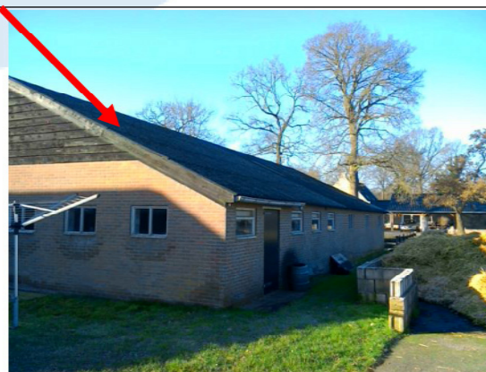
Foto 17 | Golfplaten op het dak
