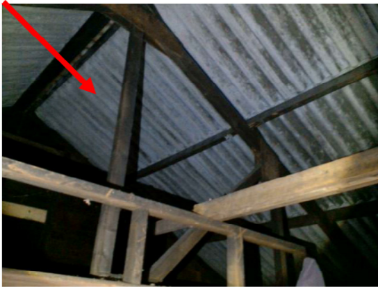
Foto 18 | Golfplaten op het dak
