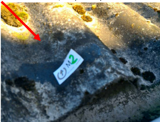
Foto 20 | Golfplaten op het dak
