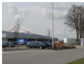
Grootchalig bedrijfsgebouw van het transportbedrijf.
