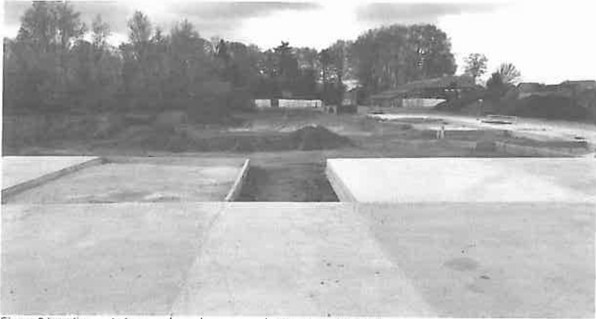
Figuur 3 Locatie van te bouwen kapschuur op reeds geplaatste fundering.
