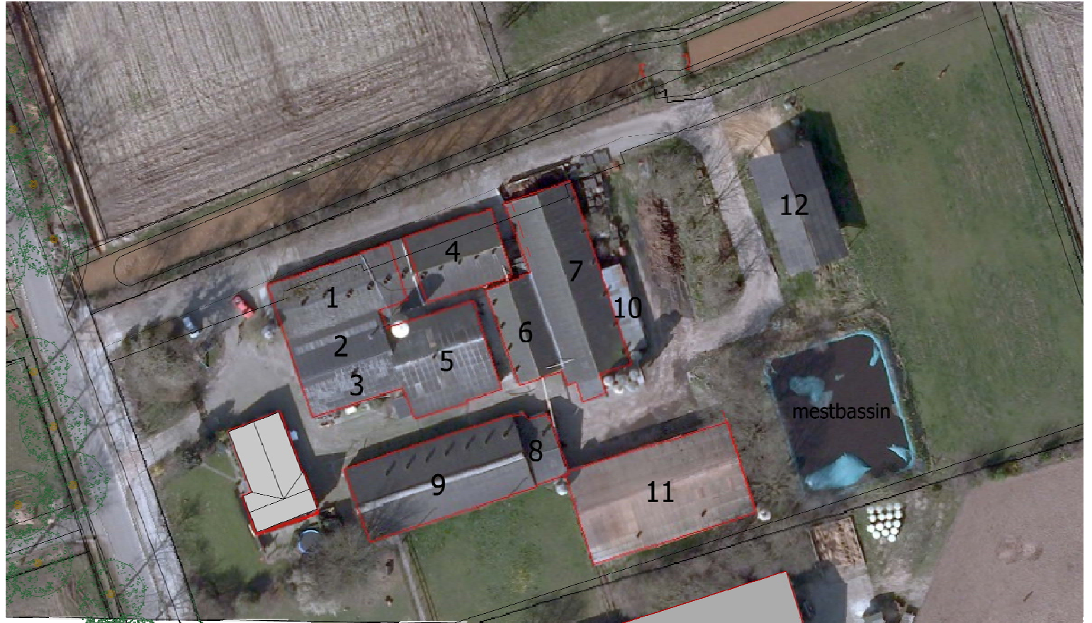
te amoveren bedrijfsgebouwen, mestbassin en terreinverharding
