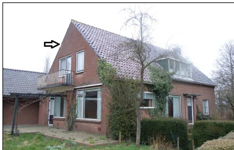
Figuur 2: Verblijfplaats van Gewone dwergvleermuis (aangegeven met pijl).
