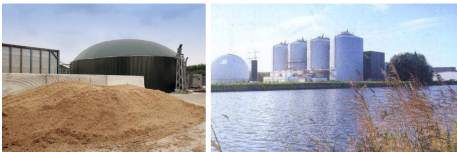
Figuur 6.19 links) mestvergister Fleringen, 170 kW e , 253 kW t rechts) ONF vergistingsinstallatie Groningen, 2,5 MW e , 3,6 MW t
