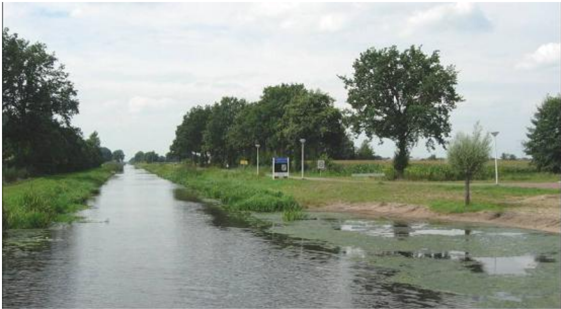
Afbeelding 16 Overijssels Kanaal gezien vanaf de Driepuntbrug
