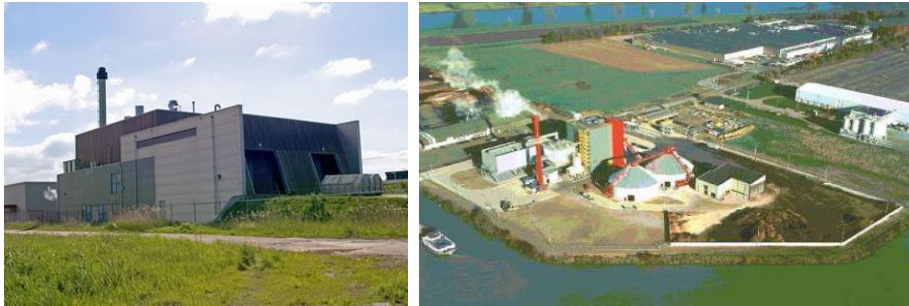
Figuur 6.18 links) Houtgestookte bio-WKK Lelystad, 1,7 MW e , 6,5 MW t rechts) houtgestookte bio-WKK Cuijk, 25 MW e , 85 MW t
