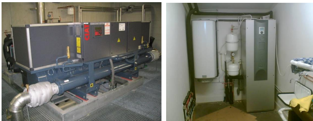
Figuur 6.7 Links) elektrisch aangedreven warmtepompen op wijkniveau Rechts) elektrisch aangedreven warmtepompen op woningniveau
