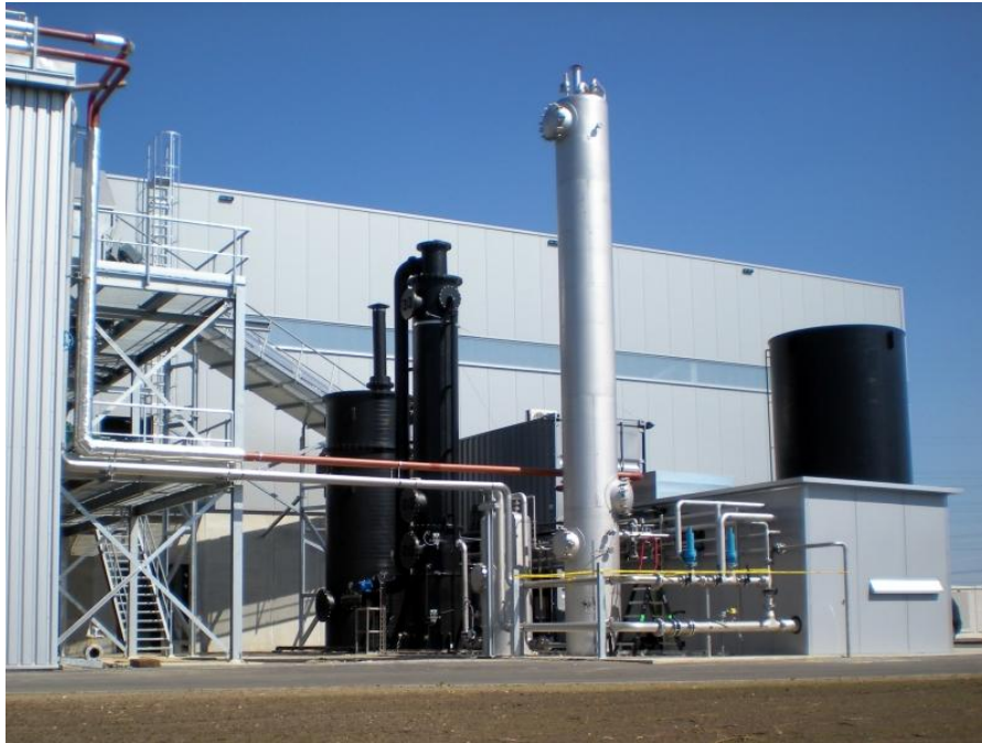
Figuur 6.20 Opwaardering gas op grote schaal, Rova in Zwolle, 700 - 1.000 m 3 /h.
