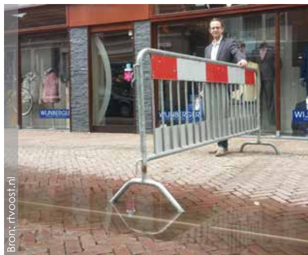
Slechte afvoer afwateringsgoot.
