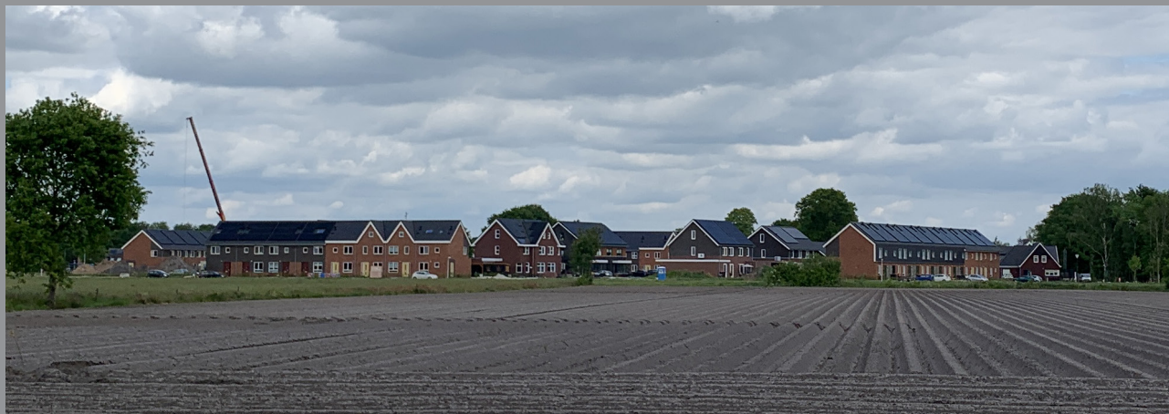
Zicht vanaf de Bouwhuisweg op deelgebied 1
