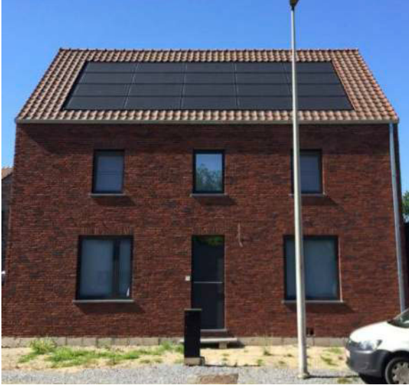
integratie pv panelen in het dak.
