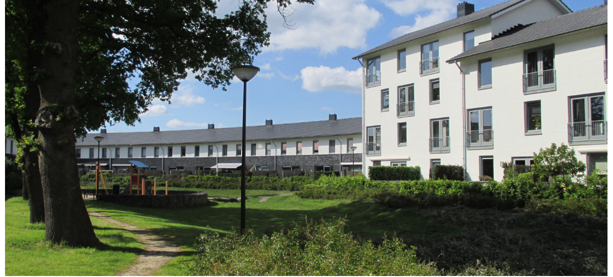
De witte kleur van de gevels is niet van toepassing, het gaat om het fijne kleinschalige beeld van gebouw in zijn omgeving
