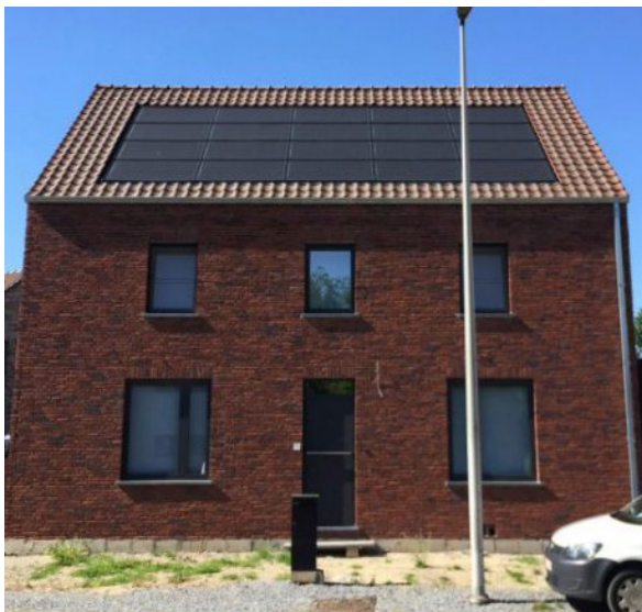
integratie pv panelen in het dak.
