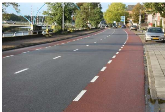
Afbeelding 4.3: Hoge kwaliteit asfaltverharding
