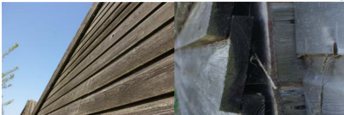
Fig. 5-2. Strak afgewerkte plankenconstructie aan schuur Fig. 5-3. Ruimte achter planken met spinrag, aan stal
