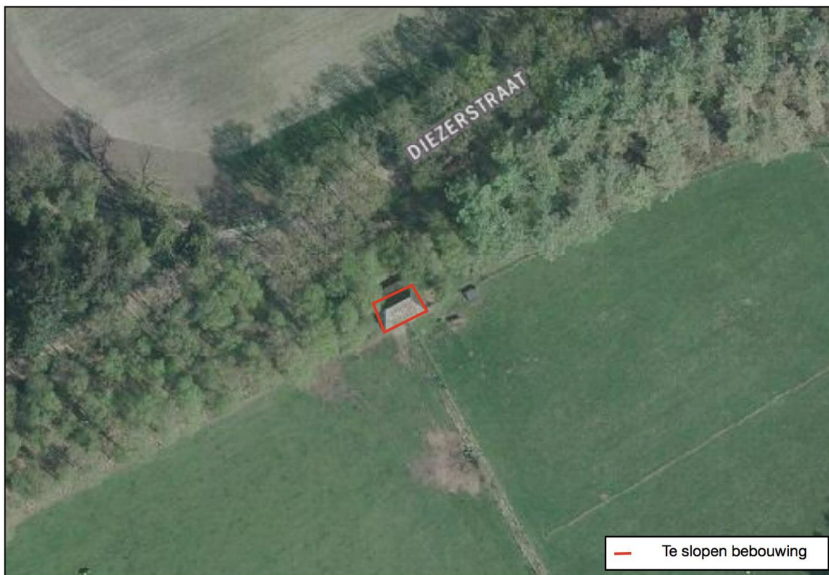
Afbeelding 2.11: Luchtfoto te slopen bebouwing Diezerstraat (Bron: Provincie Overijssel)
