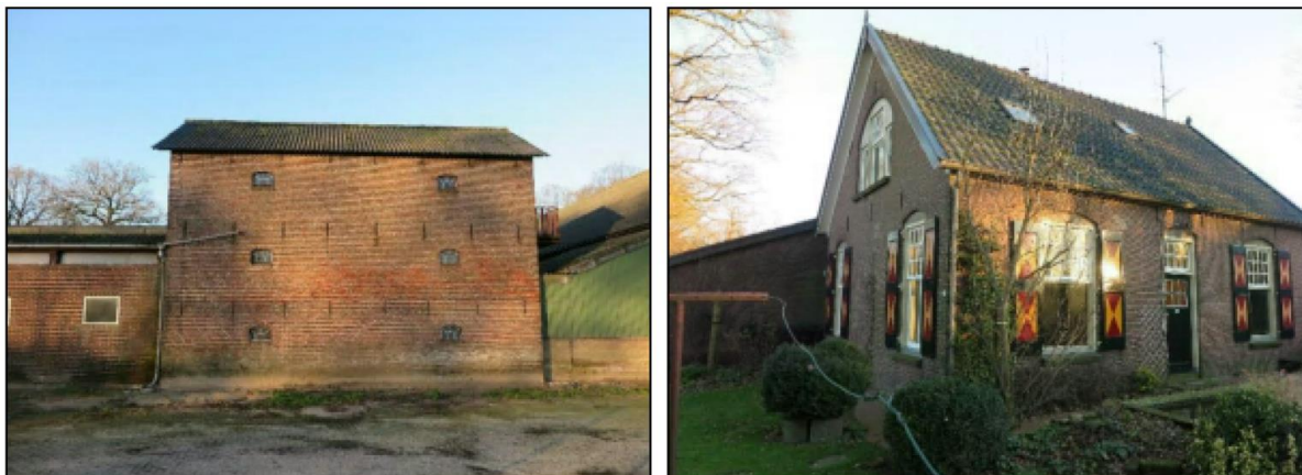
Afbeelding 2.3: Te behouden graanopslag (links) en woonhuis (rechts) (Bron: Het Rentmeestershuis)
