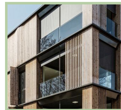
Diepte in de gevel
