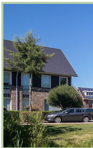
Langsgevel met overstek
