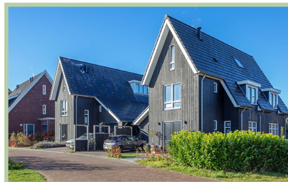
Gebakken klinkers als duurzame verharding
