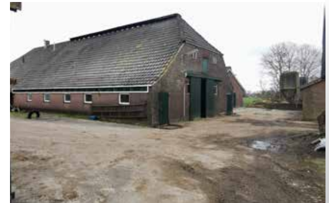
Figuur 14 Achterzijde woonboerderij, zuidkant.
