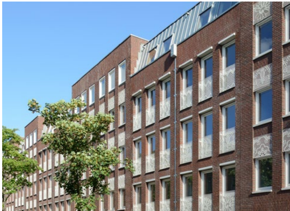
Vlakke gevel, variatie in goothoogte definieert verschillende panden
