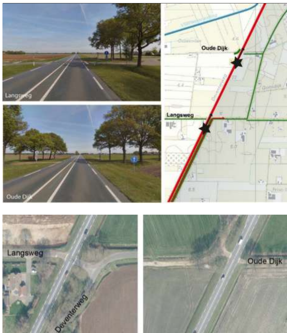
Figuur 4.108 Af te sluiten oversteken. Kijkrichting is naar het noorden gericht
