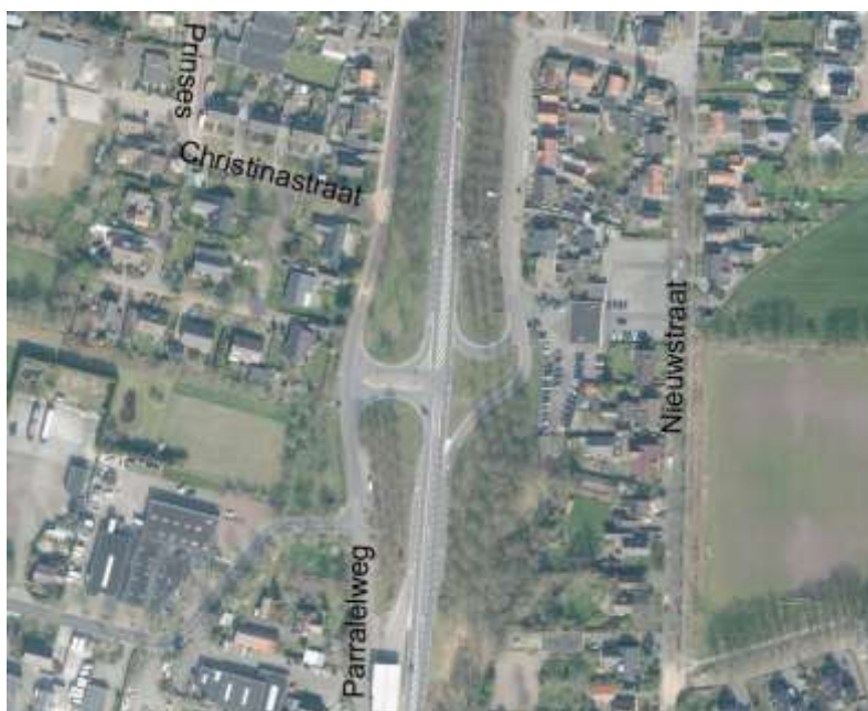
Figuur 4.83 De af te sluiten aansluiting. Kijkrichting is naar het noorden gericht.
