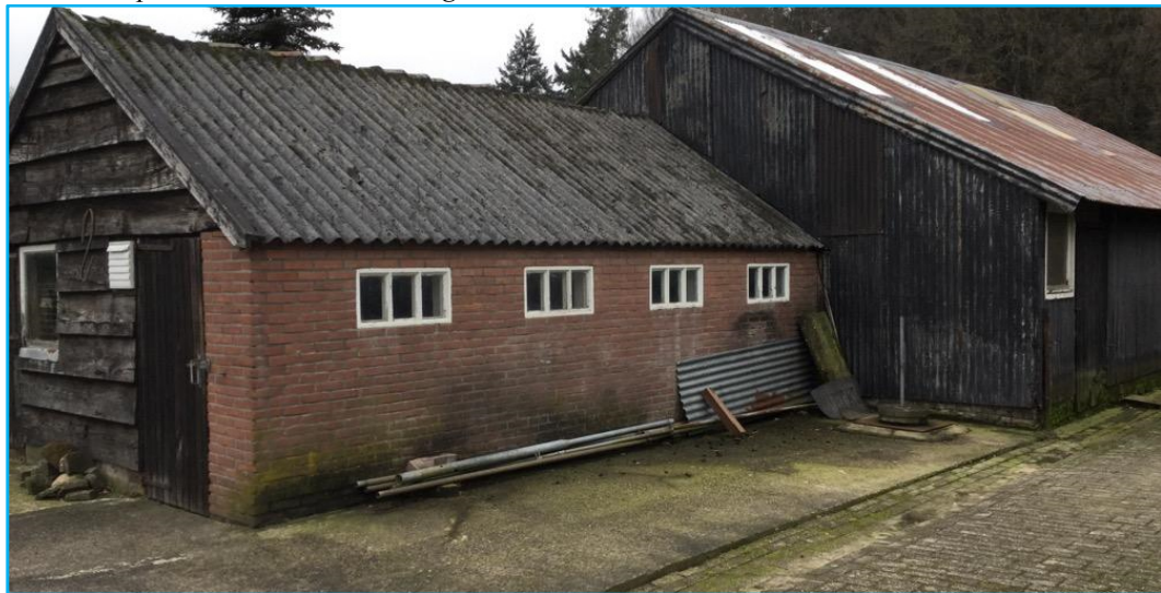
Foto 1: drupzone met betonverharding
