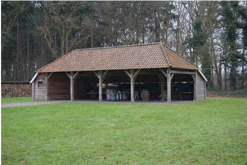
Foto 3-2 Beoogde trouw- en barbecuelocatie, ten oosten van het parkeerterrein ten zuiden van de Haersolteweg
