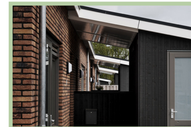
Berging onderdeel architectuur voorgevel
