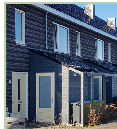
Berging onderdeel architectuur voorgevel
