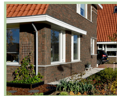
Bouwkundig accent op de hoek van een tweezijdige voorgevel
