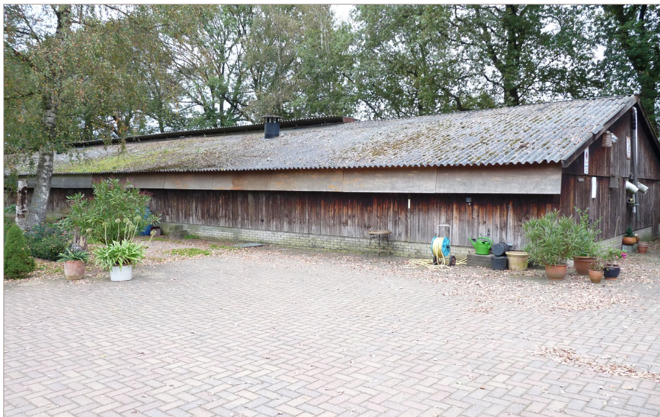
Afbeelding 22. Te slopen kippenschuur
