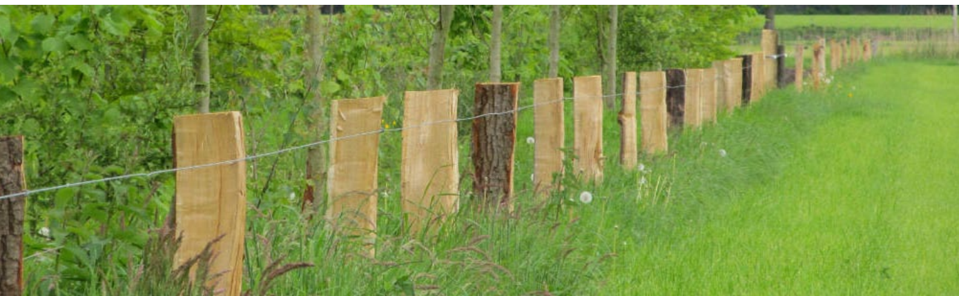
Afbeelding 34. Gekloofde eikenhouten palen voor een robuust en landelijk karakter.
