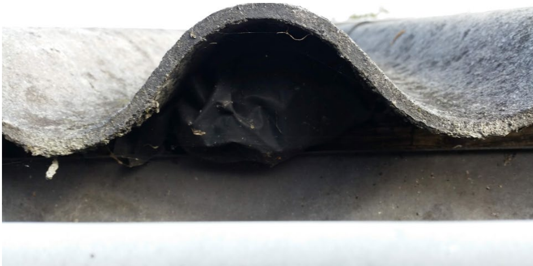
Het grootste deel van de dakrand is afgesloten
