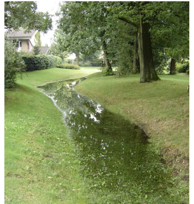
zaksloot/ wadi t.b.v. de afwatering van verharding vrachtwagen terrein
