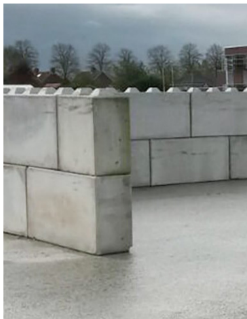
betonnen stapelblokken als lage keerwand voor grindopslag afgeschermd met beplanting
