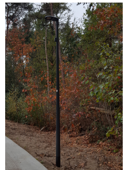
Vleermuisvriendelijke led armaturen uitgevoerd met amberkleurige leds
