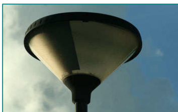
Voorbeelden van afgeschermd armaturen en lichthinderkap.
