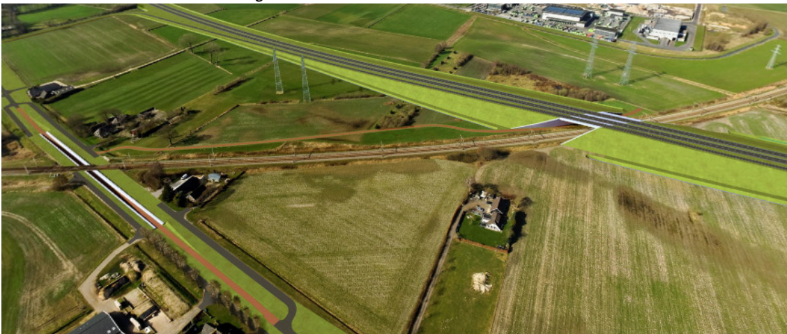
Fietstunnel onder het spoor ter hoogte van de bestaande N340 en ten noorden het Viaduct
