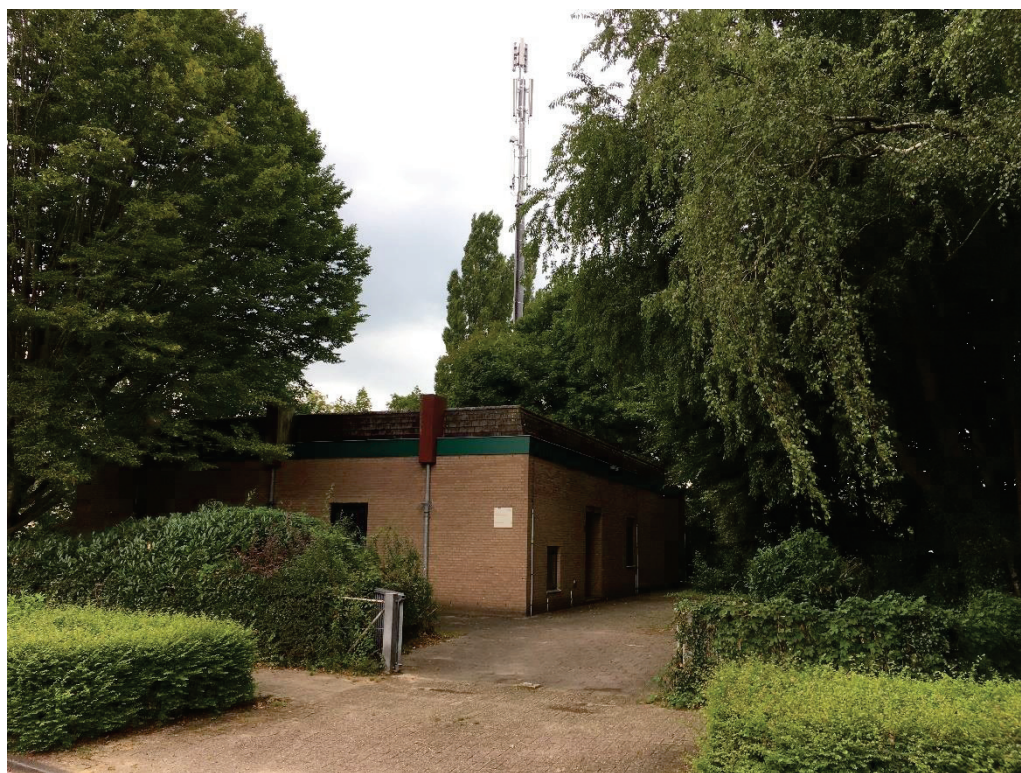
Figuur 1 - bestaande KPN-centrale
