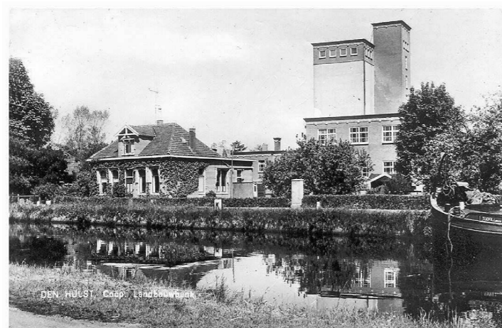
oorspronkelijke gebouw vanaf de oude Dedemsvaart
