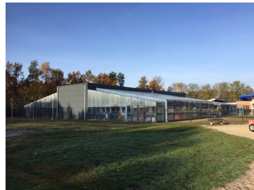
Foto zwembad na overkapping
