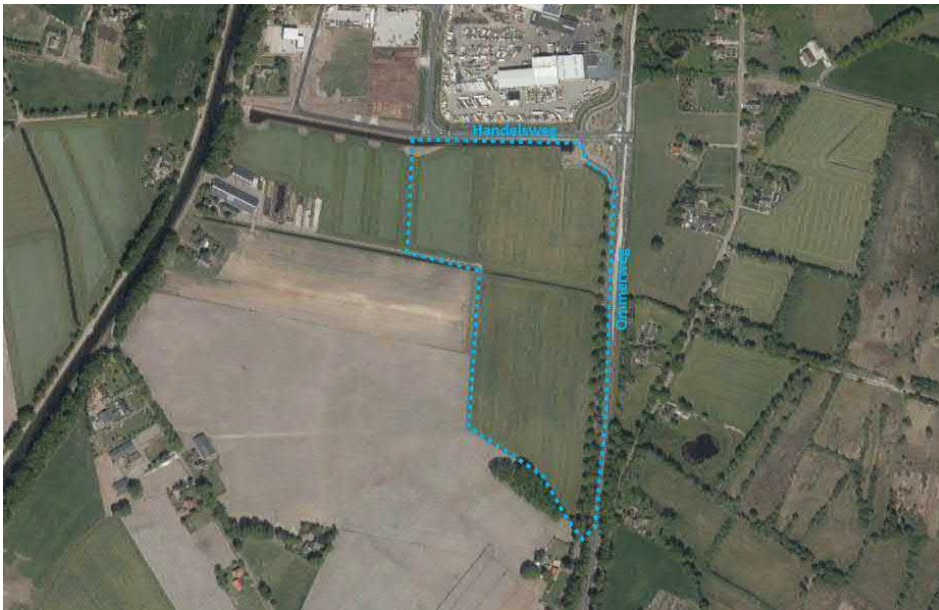
Figuur 1.1 Ligging uitbreiding (Blauw) industrieterrein t' Febriek deelgebied Stappenbelt te Lemelerveld. De nieuwe weg ligt op het industrieterrein.
