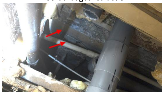
Foto 3 | verloren bekisting t.p.v. hoofddraagconstructie
