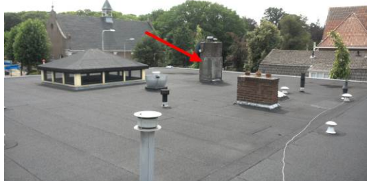
Foto 30 | plaatmateriaal om de schoorsteen
