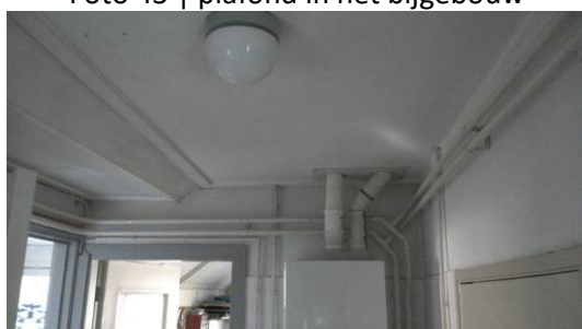
Foto 45 | plafond in het bijgebouw
