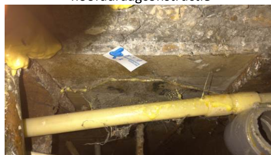
Foto 4 | verloren bekisting t.p.v. hoofddraagconstructie
