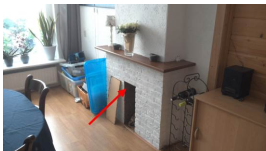
Foto 48 | verloren bekisting in de schouw
