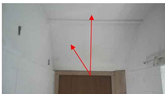
Foto 43 | plafond in het bijgebouw
