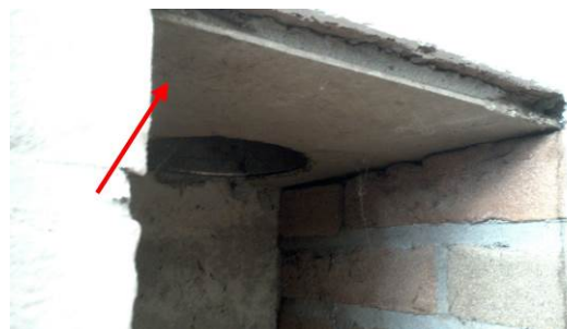
Foto 49 | verloren bekisting in de schouw
