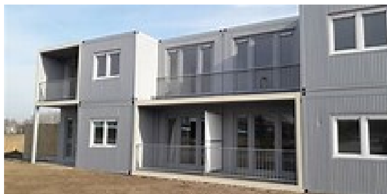
Containerwoningen in Zwolle
