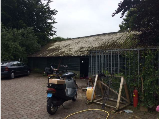
Afb. 3.2. Voorzijde schuur (nr. 1) gedeelte kennel blijft behouden
